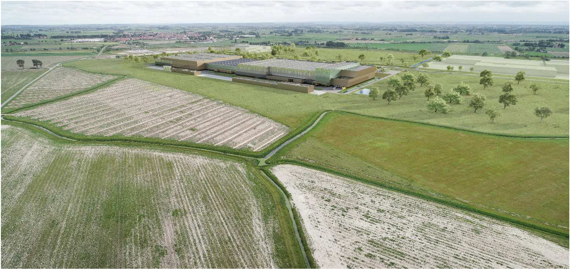
Façade nord industrielle
